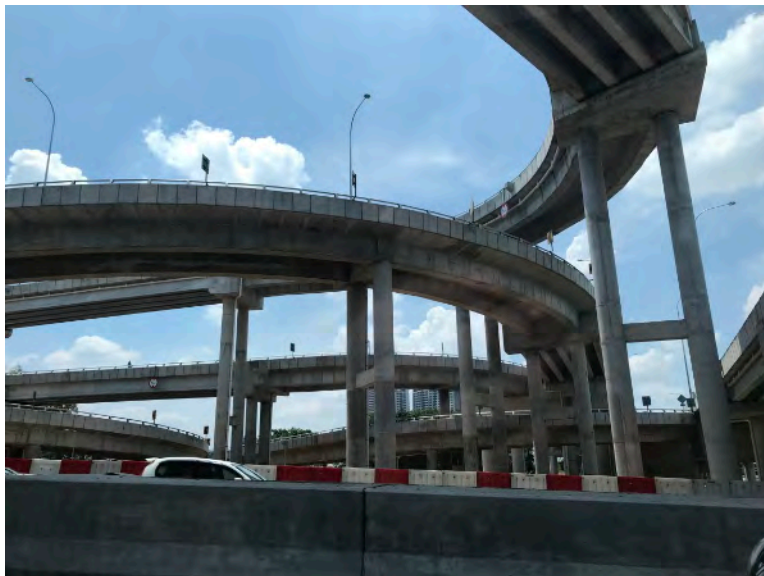
Symbolbild (Straßenbrücken Knotenpunkt Subang Jaya, Malaysia)
